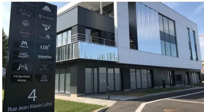
Bureau de PA Services, bâtiment "Le Bizen"
