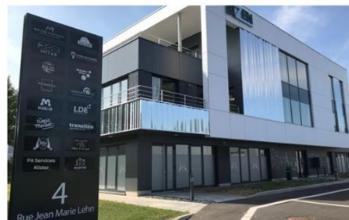
Bureau de PA Services, bâtiment "Le Bizen"
